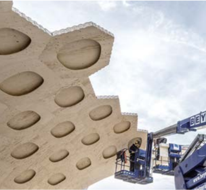
→ Les segments de caissons creux ont été partiellement préassemblés et puis assemblés sur place sans structure porteuse ni échafaudages.
