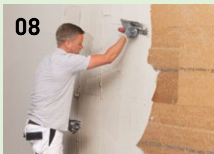
De op de muur aangebrachte wandplaten met een getande troffel en PP Fill volledig dichtstrijken.
