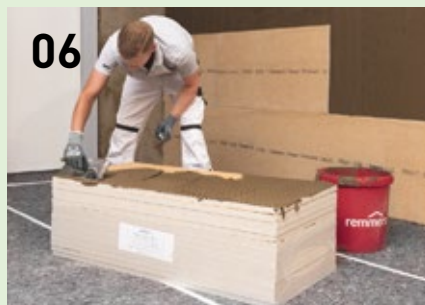
Voor een volledige hechting op de isolatieplaten wordt PP Fix met een getande troffel op wanden en platen aangebracht.
