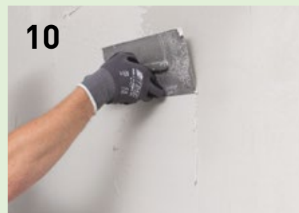
Fijnpleister IQ Fill doorroeren en op de wand aanbrengen. In uitgeharde toestand is de pleisterlaag diffusie-open en waterbestendig.
