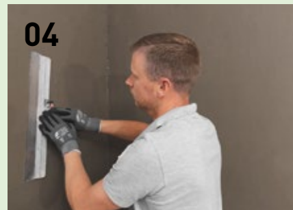
Ondergrond met hechtmortel PP Fix en een brede afstrijkspatel egaliseren (tot 8 mm).
