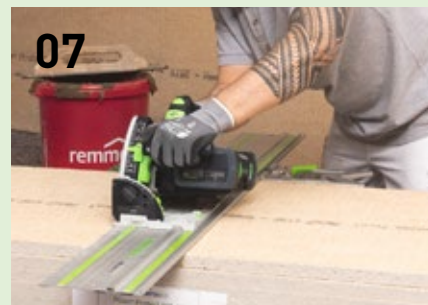
Wandplaten met Festool TSC 55 en geleiderails op maat zagen. Uitstekende kanten indien nodig bijschuren met de ETS EC 150/5.
