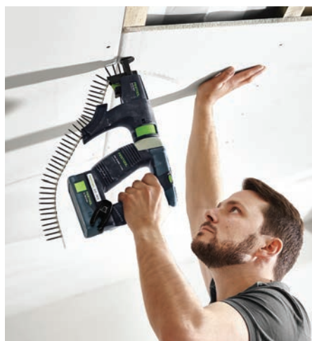
Snel werken met magazijnadapter.
