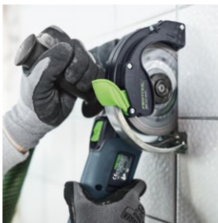
Vue dégagée sur l'emplacement de coupe
