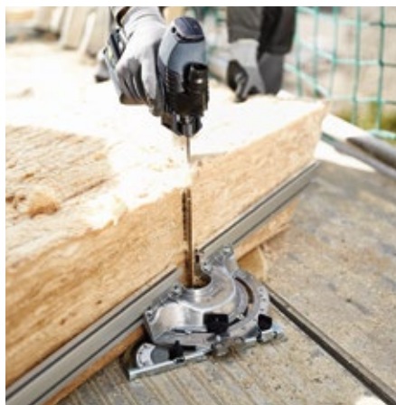
Découpe sans difficultés, même sur un échafaudage
