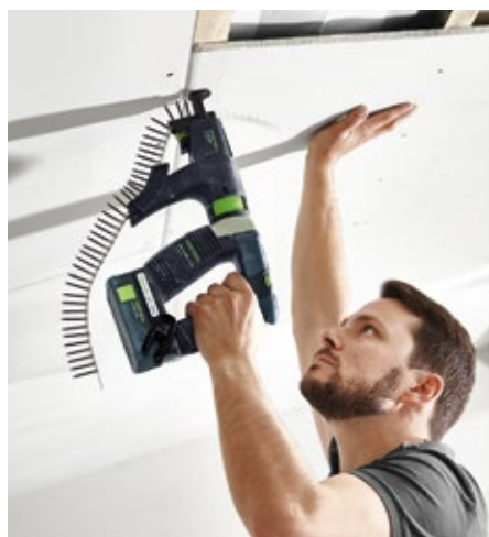
Cadence de travail rapide grâce au chargeur de vis
